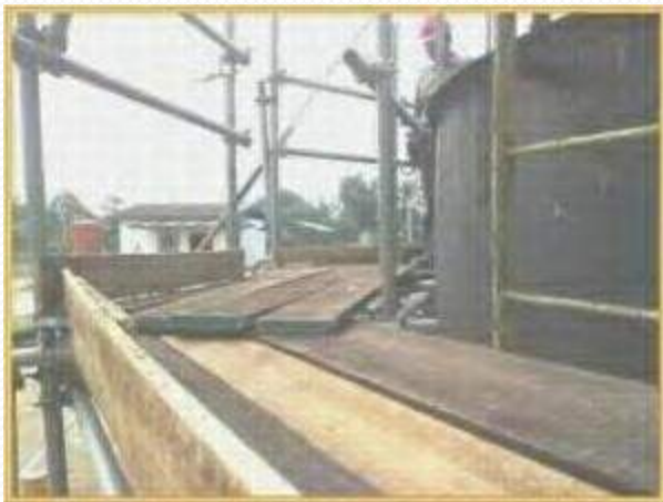
Penyambungan Round Scaffold
