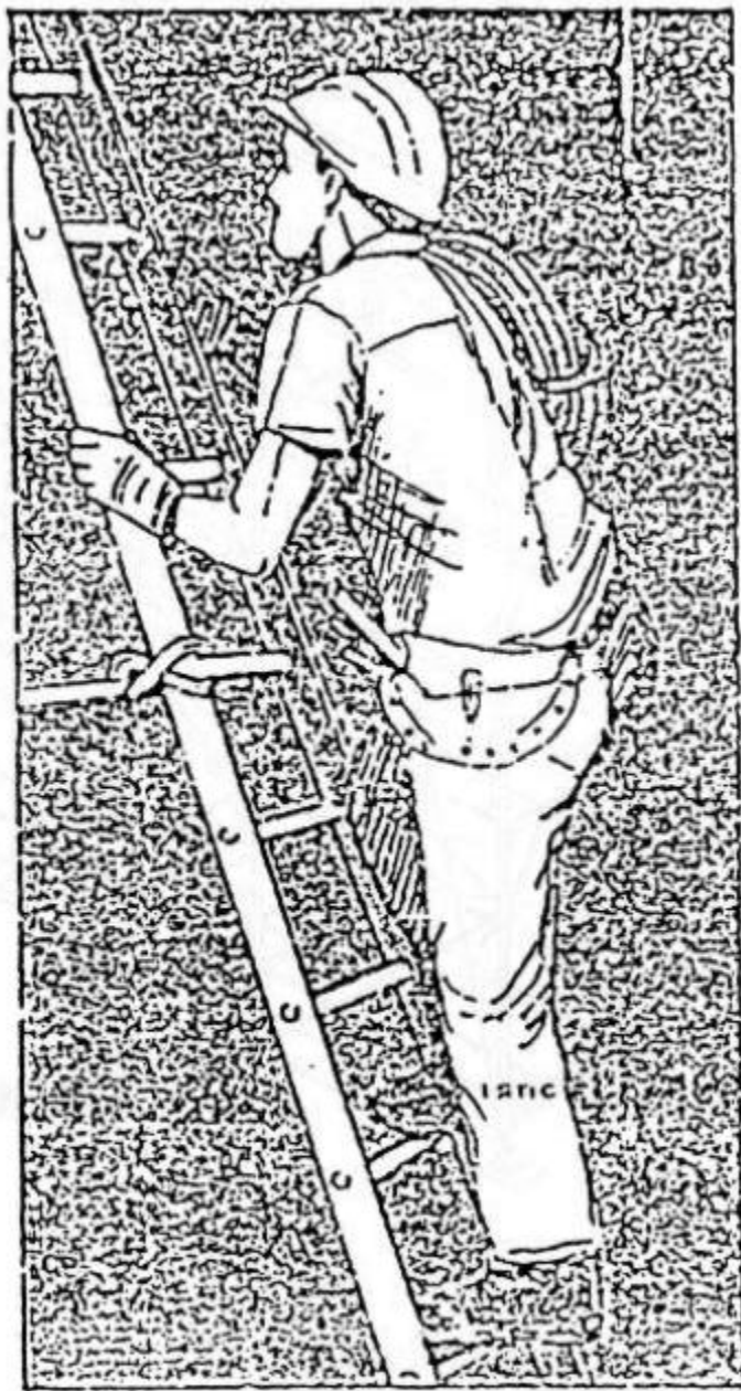
Menggunakan kedua tangan sewaktu memanjat tangga.
